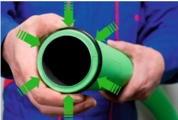
3) Der „O“ Dichtungsring wird in die Rille am Außenrand des Rohrs eingedrückt.
