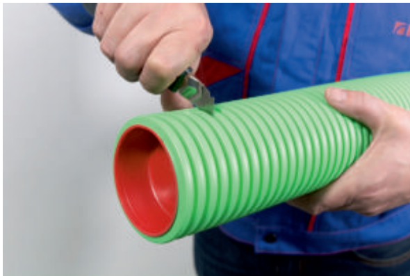
1) Das Rohr wird in einer Rille auf die gewünschte Länge geschnitten.
