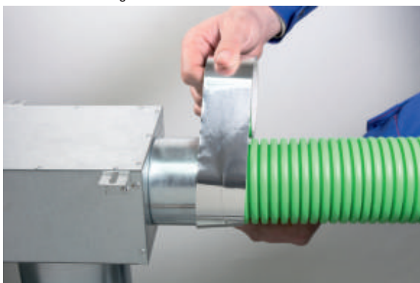
7) Die Verbindung ist mit einem luftdichten Band abzudichten.
