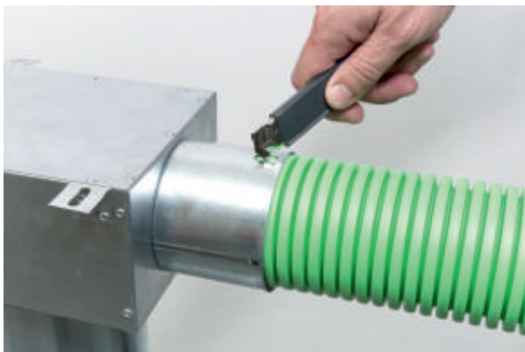
5) Beide Klemmen zur Verhinderung des Ausrutschens des Rohrs werden eingedrückt.
