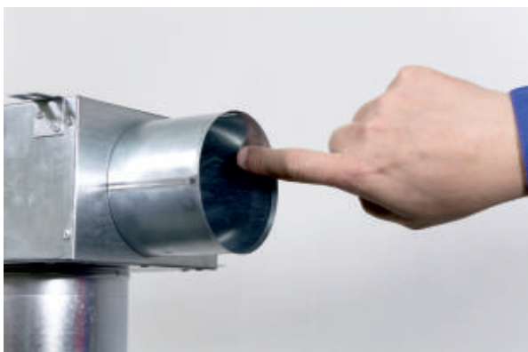
3) Die Innenseite des Ausgangs ist mit einem Gleitmittel zu schmieren*.
